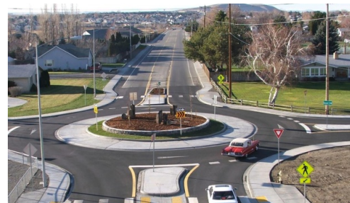
写真-1 海外のラウンドアバウト設置事例
