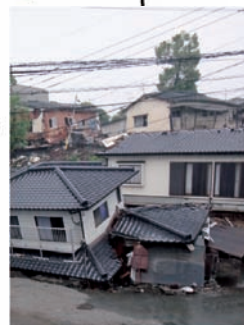
地震による倒壊
