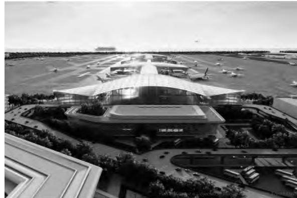
(ウタパオ国際空港の新滑走路とターミナルの完成イメージ写真)
