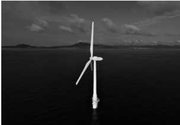
図2：崎山沖2MW浮体式洋上風力発電所 (出典：戸田建設HP)
