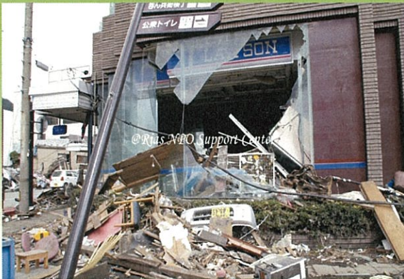
2011年3月 凄まじい波と漂流物によって破壊された店舗。
