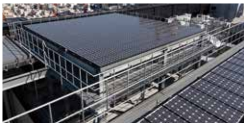
駿河台新館屋上に設置した太陽光パネル
