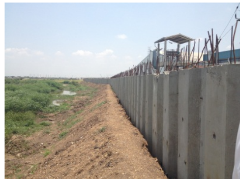
ロジャーナ工業団地で建設中の輪中堤と防水壁 (建設開始当時、構造がよくわかる状態で撮影)
