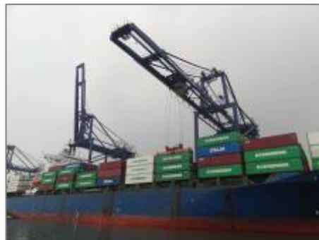
コンテナターミナルの様子 (JICT)
