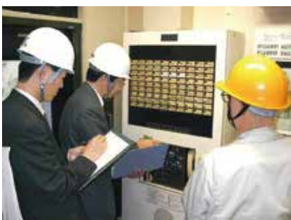
現地調査の様子
